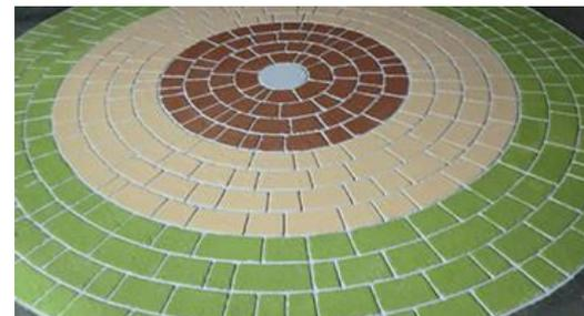
ブロック柄や舗石柄がパターン化された特殊なワイヤーメッシュ（テンプレート）を用いて、敷きならしたアスファルト舗装あるいは再加熱した既設アスファルト舗装の上からテンプレートを圧入し、しばらくして取り外すと、テンプレートのパターンがそのまま舗装表面に転写されます。
