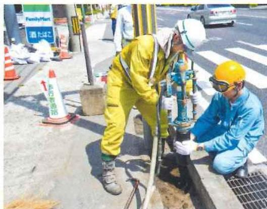
人力施工で大型重機不要。施工幅は200mmの省スペースです。これまで基礎工事に必要だった時間と工事占有スペースを大幅に圧縮でき、施工に伴う交通渋滞リスクを軽減できます。
