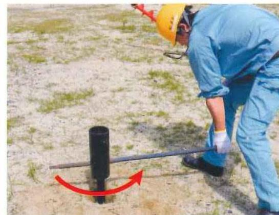
杭基礎方式はこれまでの交換メンテの常識を大きく変えます。基礎撤去は専用治具で引き抜くだけ。引き抜きと締固め後はまったく同じ場所に再打設が可能です。
