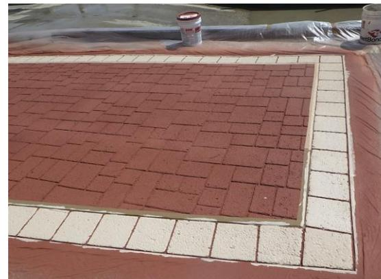
専用樹脂系塗料により耐久性に富み、ブロック舗装に散見される段差やガタツキが生じずに良好な走行性・歩行性を確保すると同時に型押しされたテンプレートの痕が模擬目地になるため、降雨時の水切りが良くなります。
