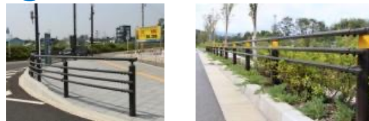
車両用防護柵 (ガードパイプ)
