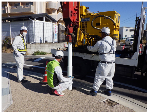
支柱・杭の打ち込み
