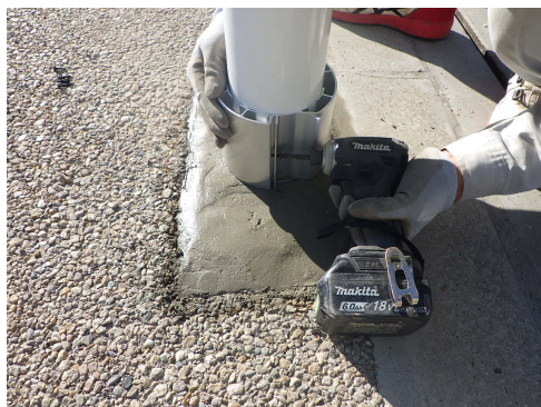
取付金具 設置
