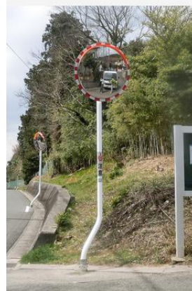
施工事例04 (所要時間 32分)
