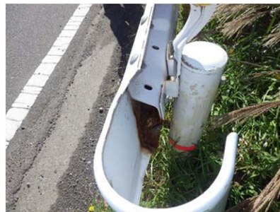
そでビームとビーム本体のコルゲーションとの隙間の腐食
