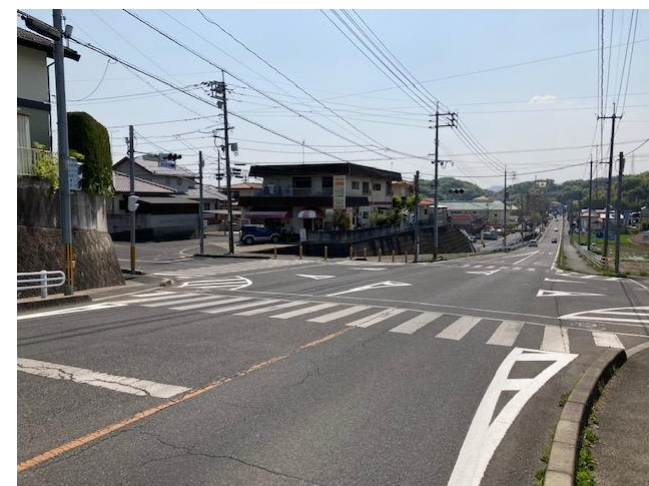
施工場所 岡山県総社市
