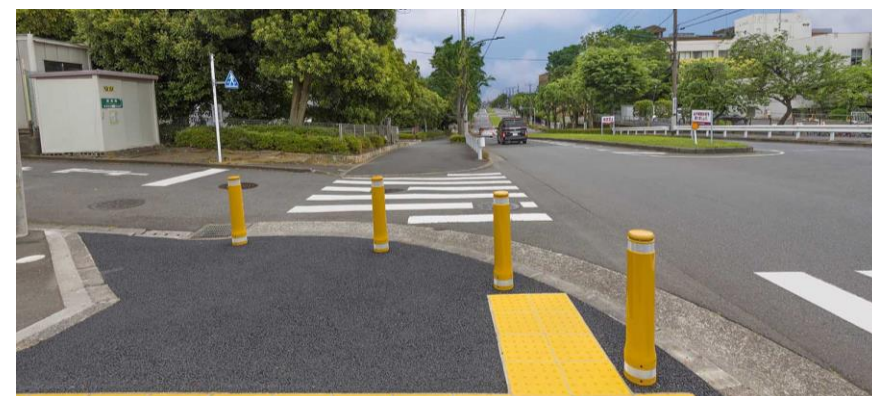
施工場所 東京都内
