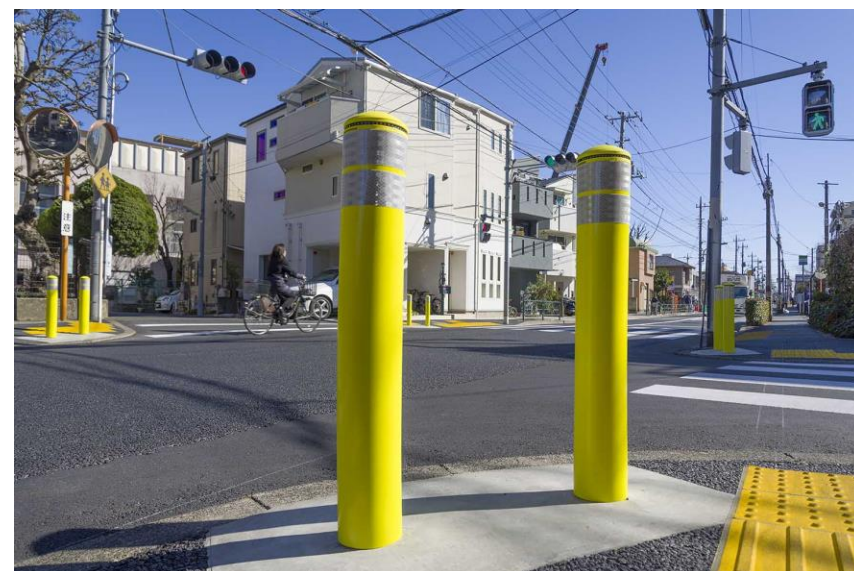
施工場所 東京都内
