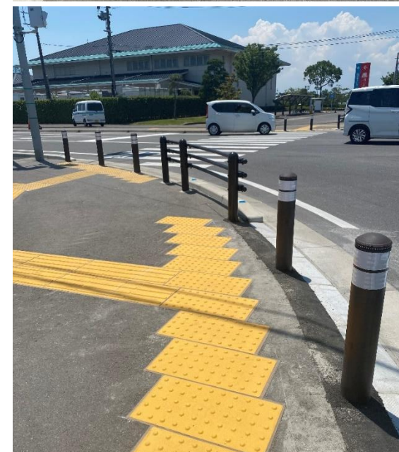
施工場所 佐賀県 白石町
