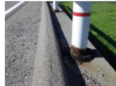
支柱の地際部
