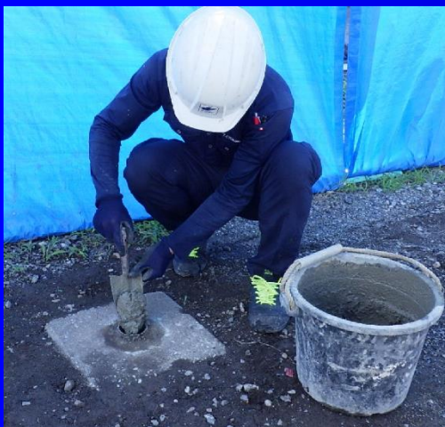
● モルタル注入
