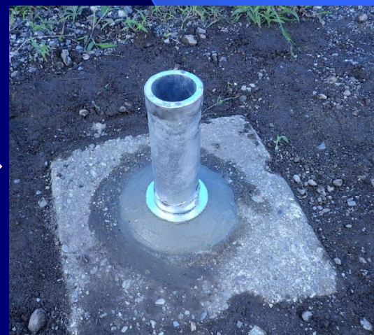
● SDジョイント建込後
