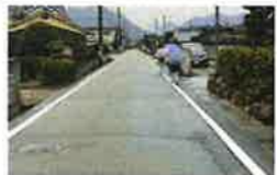
道路区画線を引き直した後の県道門柳大門線＝西脇市
