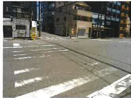
6割以上が消えている横断歩道を補修
