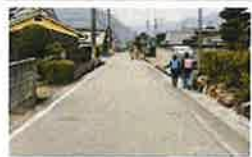
道路区画線を引き直す前の県道門柳大門線＝西脇市黒田庄町岡(兵庫県提供、2023年1月18日撮影)
