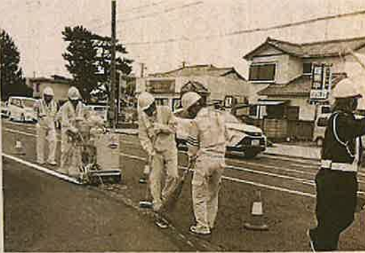
区画線の引き直し作業。安全運転支援システムの機能発揮につながるとして県が緊急的に進めている＝静岡市
