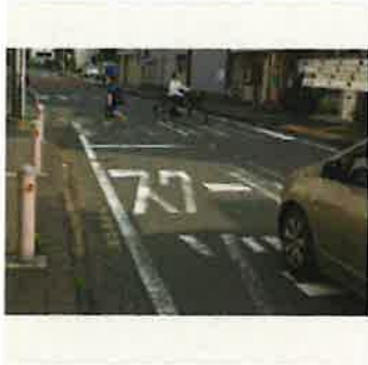
白線が薄くなった中央線や横断歩道 =横浜市神奈川区の市道で2023 年6月21日午後4時27分、柿崎 誠撮影
