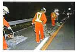
夜間に道路の区画線を引き直す業者＝西宮市樋ノ口町2
