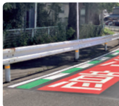
▲ガードレール支柱に設置された「黄色視線誘導反射シート」
