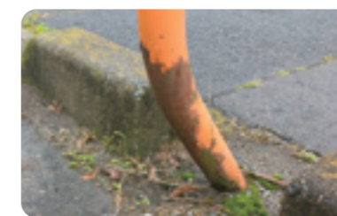
▲点検状況の写真の一例
