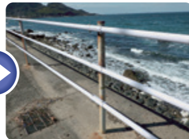
▲左の写真の状態から腐食部分のみ交換
