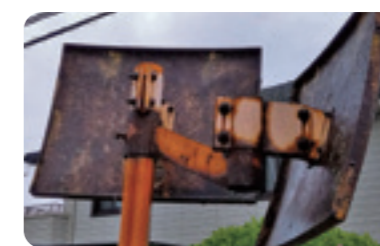
▲点検状況の写真の一例
